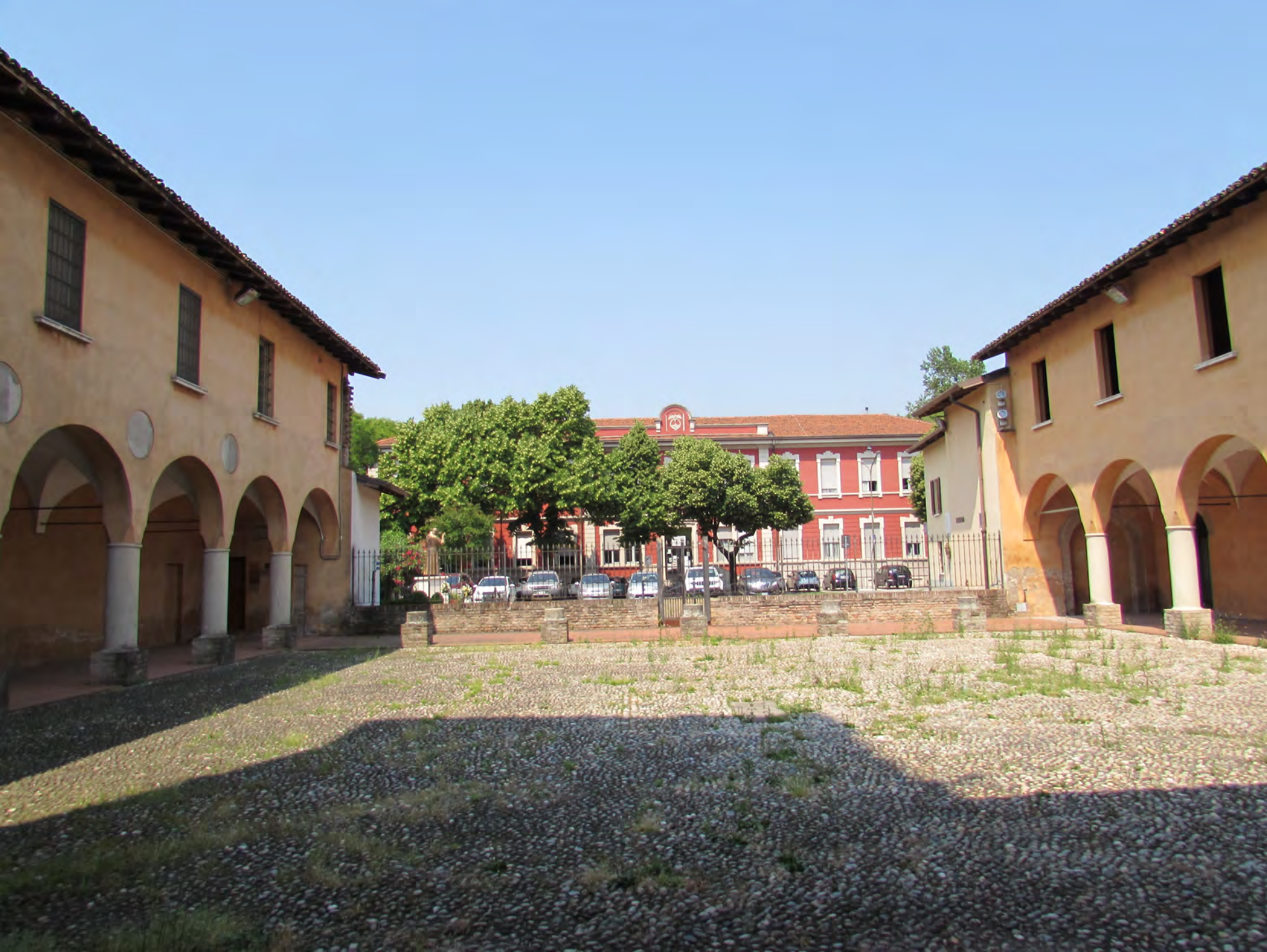
ESISTENTE - interno chiostro
